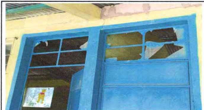
Foto 3: sustitución de vidrios en puertas y ventanas
