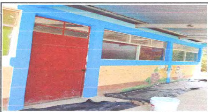
Foto 5: Pintura del exterior de las aulas
