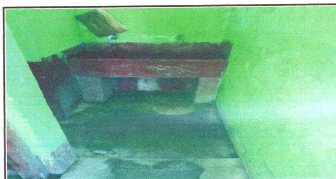
Foto 5: Sustrucción de grifos (4)
