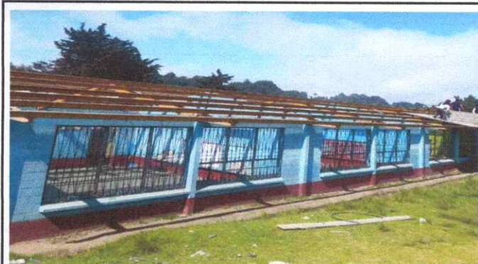
Foto 3: Se puede observar que en este momento empiezan a desmontar la lamina existente
