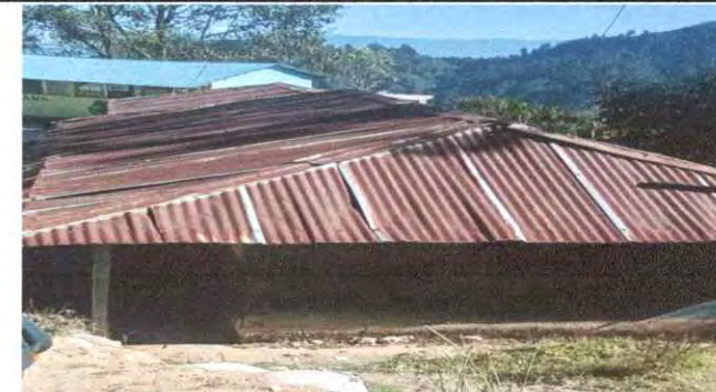
Foto 6: sustitución de lamina por lamina acanalada
