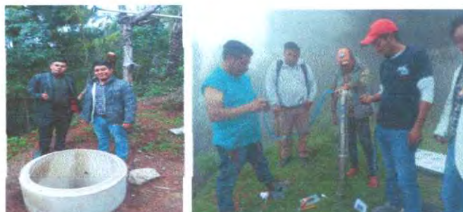
Foto 6. Colocando bomba de agua, en pozo escolar, para beneficio de los niños y niñas del establecimiento
