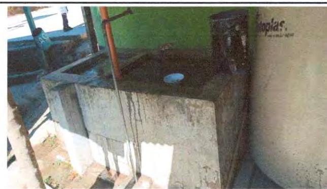
Foto 4: sustitución de pila
