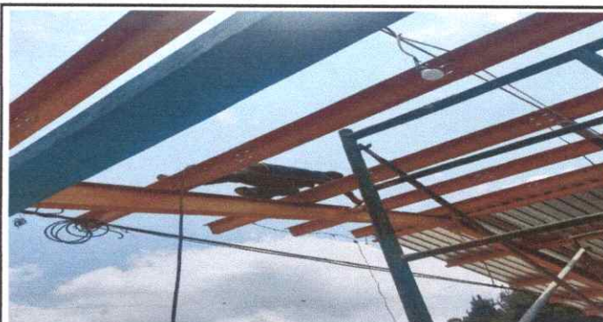
Foto 6: Se puede observar que se esta pintando la estructura existente.
