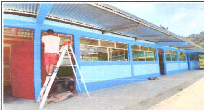
Foto 4: Pintura del exterior de las aulas
