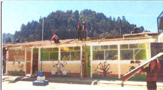
Foto1: Cambio de techo
