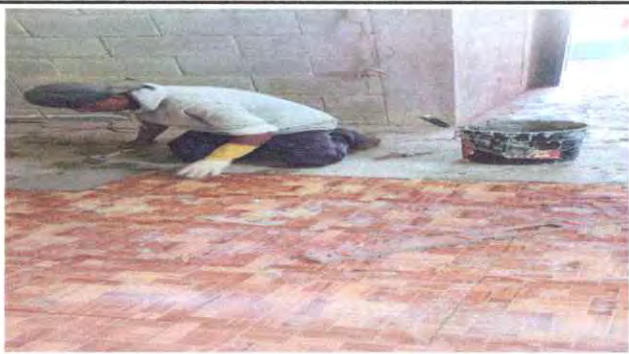
Foto 3: Pisos ceramicos interiores
