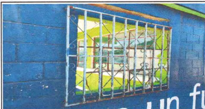
Foto 8: Fabricación e instalación de ventana balcón de metal
