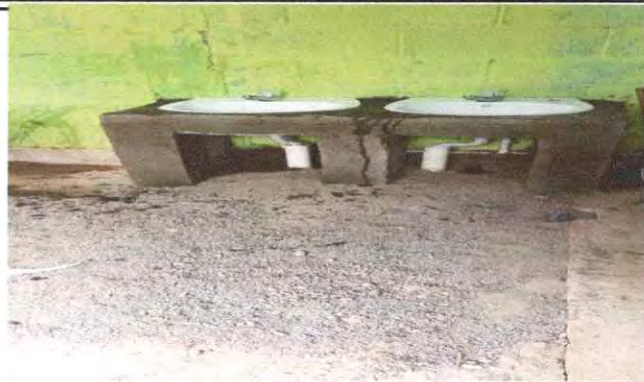
Foto 2: Sustitución de lavamanos
