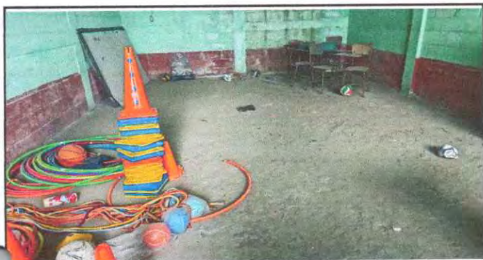
Foto 9: Sustrucción de piso de torta de concreto
