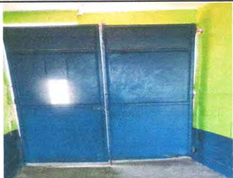
Foto 7: Sustrucción de puertas
