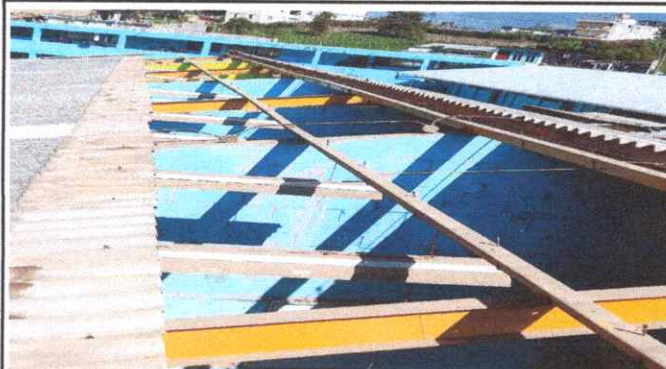
Foto 2: Se puede observar que en este momento empiezan a desmontar la lamina existente
