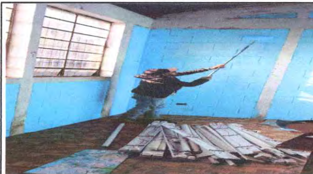
Foto 2: pintura de paredes interiores
