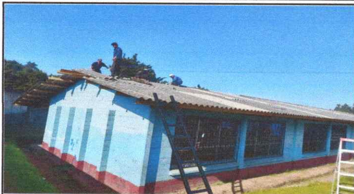
Foto 1: Se puede observar que en este momento empiezan a desmontar la lamina existente
