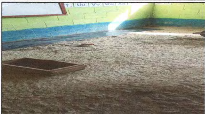
Foto1: sustitución de piso de torta de cemento por cerámico
