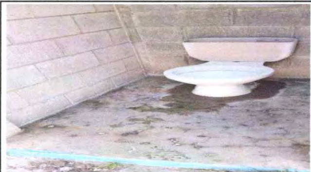
Foto 4: Mejoramiento de servicios sanitarios
