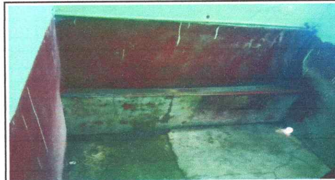
Foto 4: Sustrucción de mingitorio (1)
