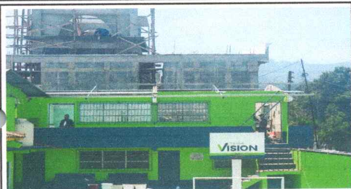
Foto 1: Sustrucción de canal de PVC, sustrucción de bajada de agua pluvial de metal por tubo PVC y sustrucción de soporte o pescante de metal para canal.
