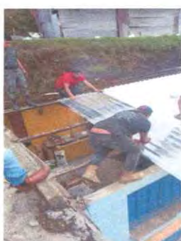
Foto 3: Cambiando techo en mal estado, Se filtra agua en todo el invierno
