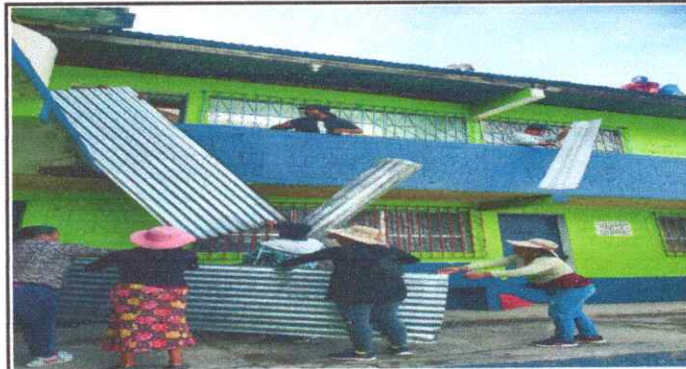
Foto 2: Sustrucción de lámina por lámina troquelada, sustrucción de capotes de lámina por lámina troquelada, sustrucción de elementos de fijación, sustrucción de estructura de soporte de madera por metal.
