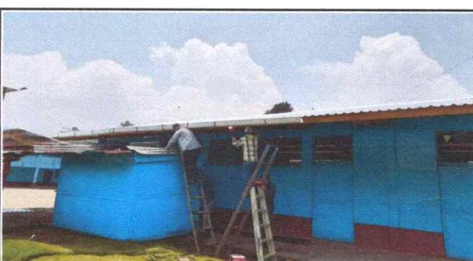
Foto 6: Instalacion de canales y bajadas de agua pluvial.
