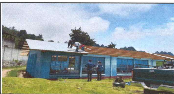
Foto 5: Se puede observar que ya se empezo a montar la lamina troquelada.
