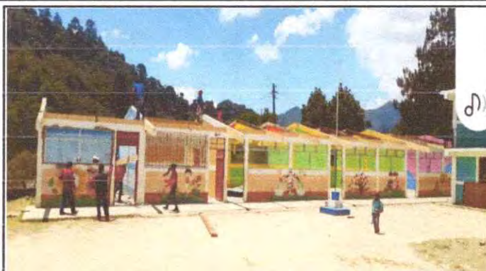
Foto 2: Cambio de techo
